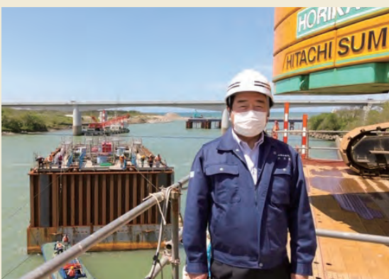
大河津分水路改修工事第二床固大型ケーソン川底設置 (R2.5.5) 【大河津分水河口】
