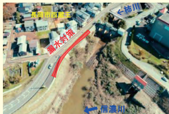
④長岡市西蔵王地先 堤防強化(漏水対策)
