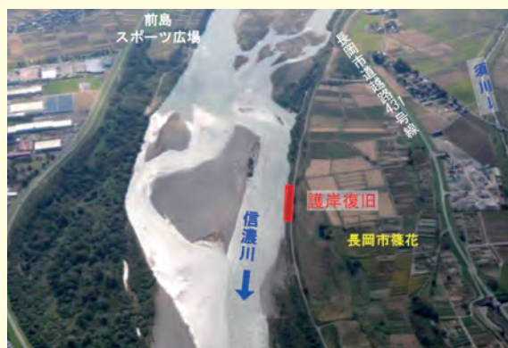
⑦長岡市篠花地先 護岸復旧
