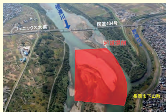
⑤長岡市下山町地先 河道掘削、樹木伐採
