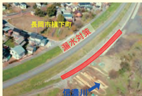
④長岡市横下町地先 堤防強化(漏水対策)
