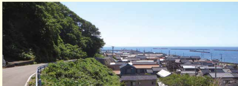
国道352号道路改良 海岸側
