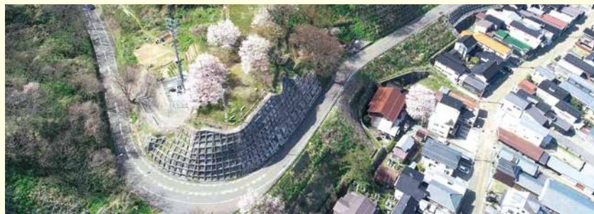
国道352号道路改良全景
