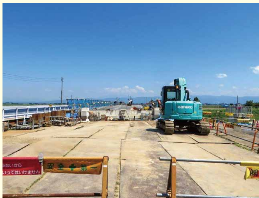
七日市橋上部工
