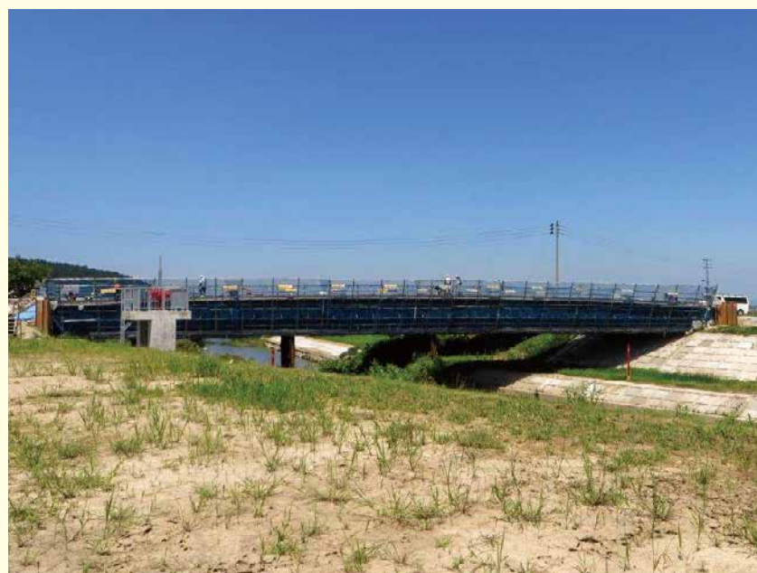
七日市橋工事全景
