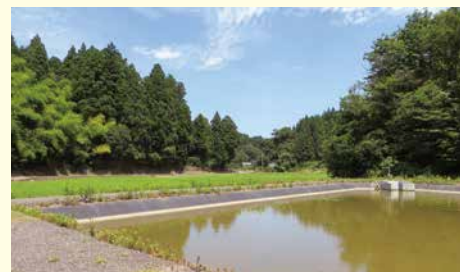
田中地区(ファームポンド)
